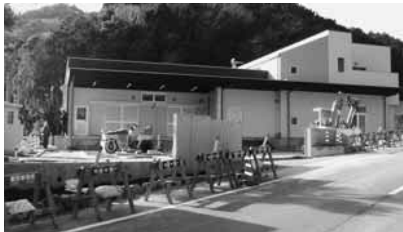
完成間近の河津町学校給食センター
