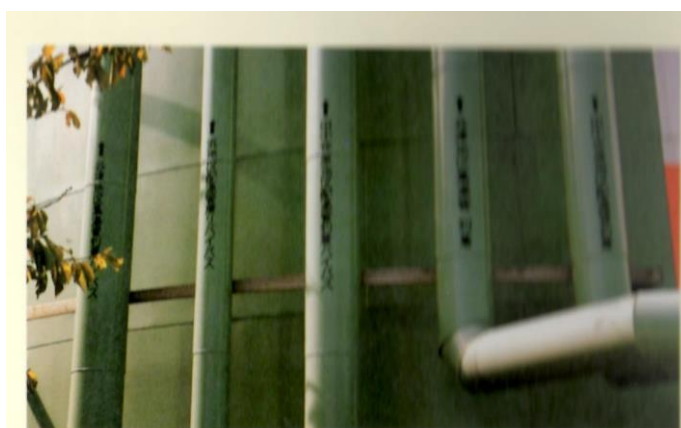
パイプライン
