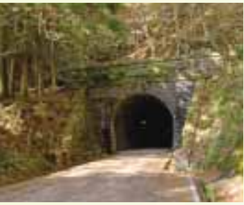
旧天城トンネル
