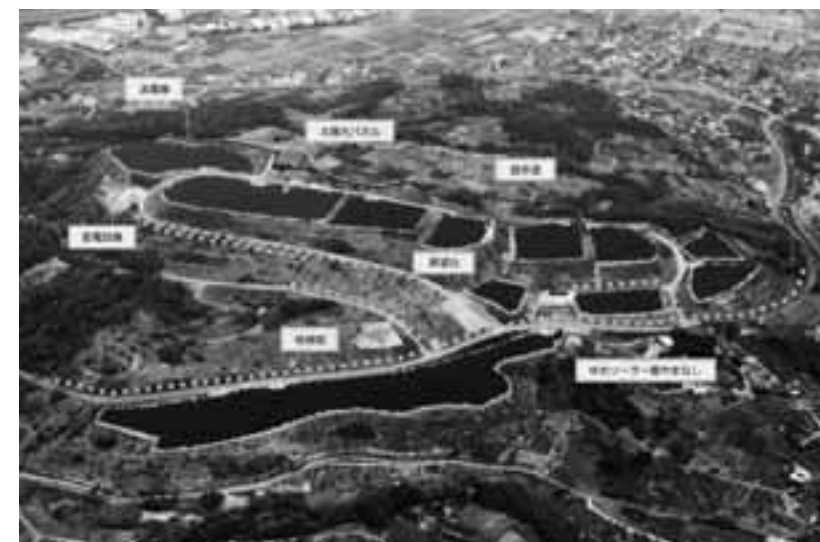
米倉山太陽光発電所全景
