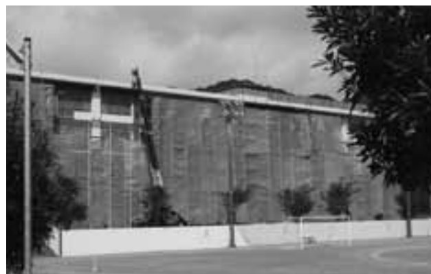
(工事中の河津中学校)
