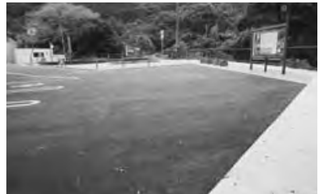
佐ヶ野遊歩道整備工事
