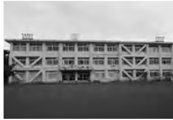
東小耐震工事
