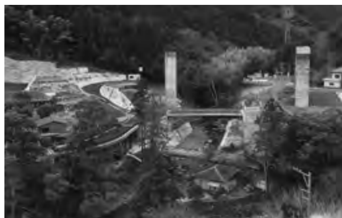
縦貫道工事現場(大鍋)
