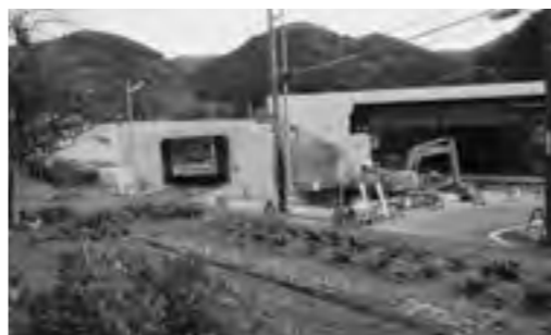
縦貫道工事現場(逆川)
