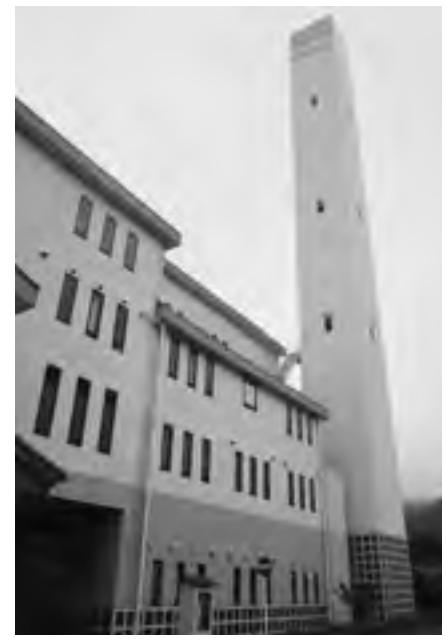
東河環境センター
