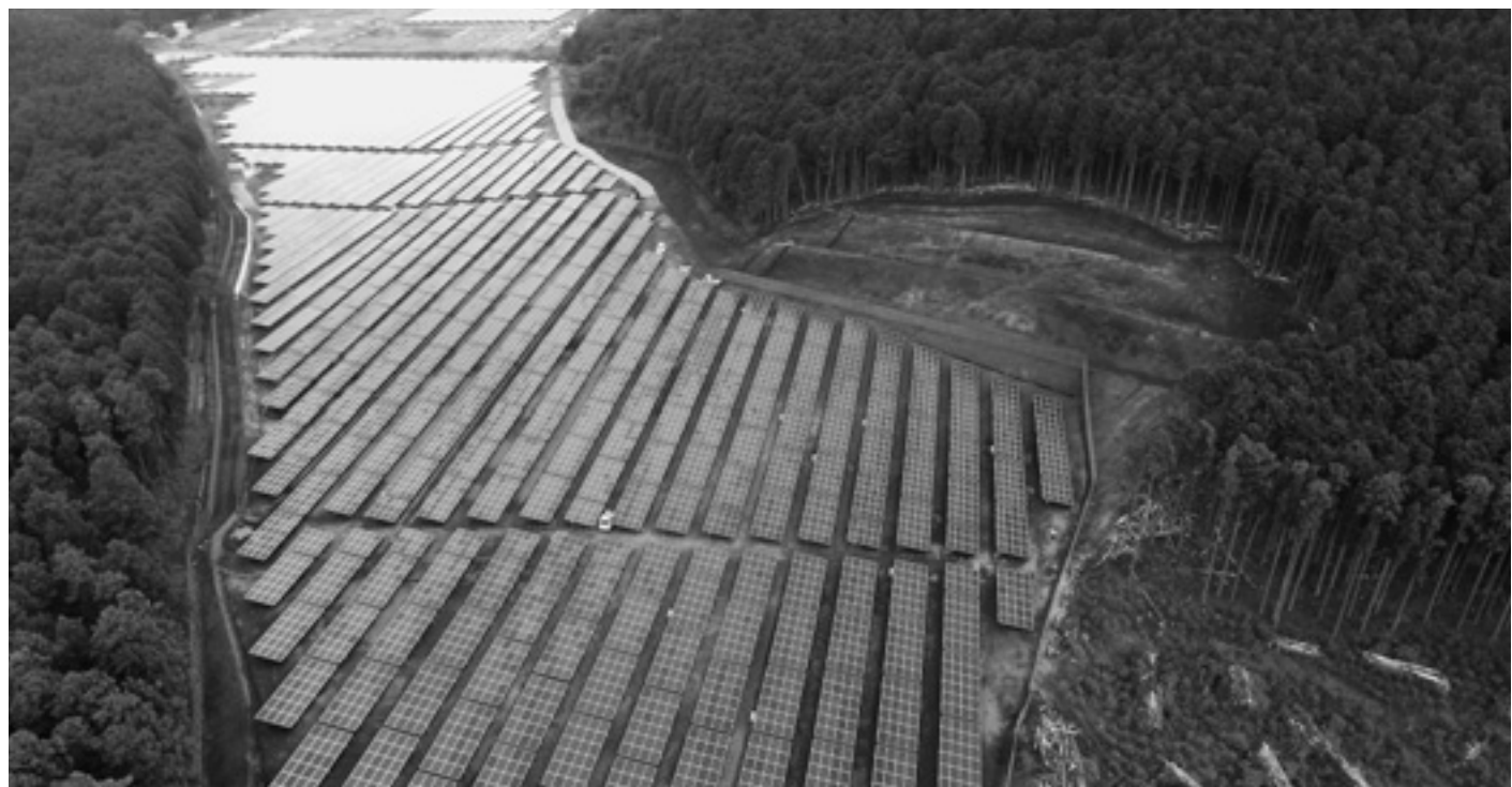
鉢ノ山現場全景
