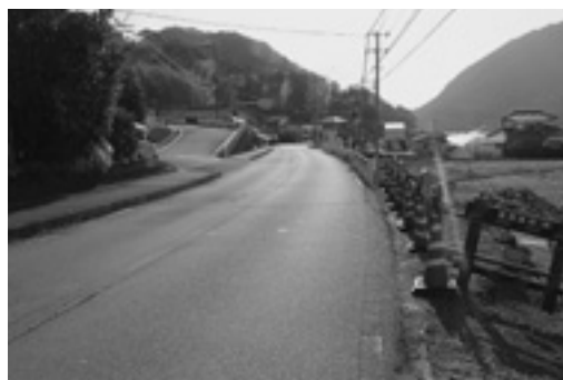
大堰笹原線の道路改良 ハジット山付近
