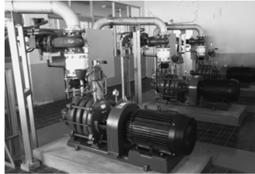
大堰浄水場のポンプ入替事業
