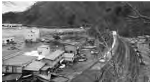
大津波を食い止めた太田名部防潮堤
