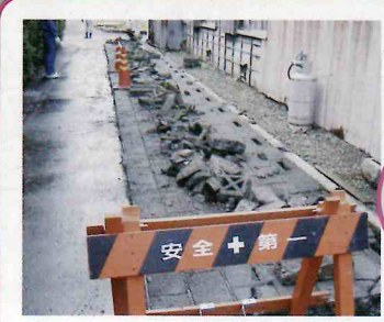
駿河湾を震源とする地震による ブロック塀の倒壊
