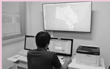
同報防災無線やJアラート受信機の交換を行った統制台
