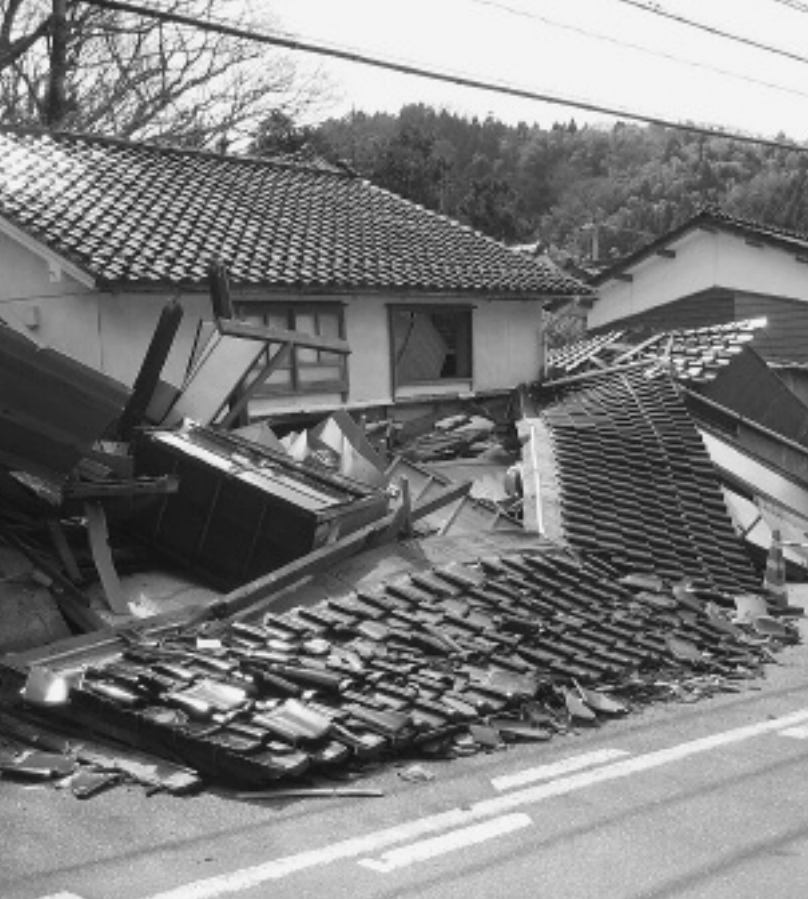
能登半島地震（平成19年）で倒壊した木造住宅 （写真提供：県建築安全推進室）
