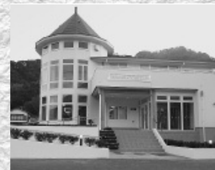
建物川側からの外観
