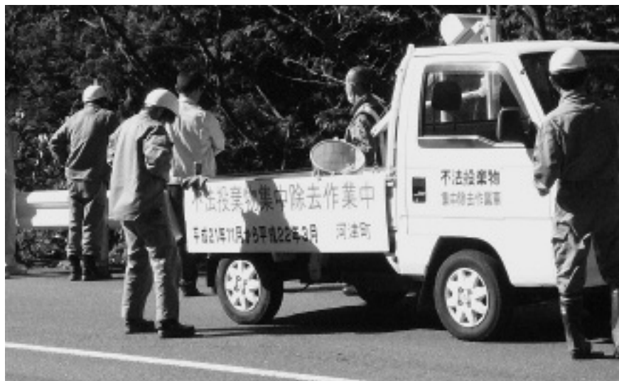
国道414号 現地確認
