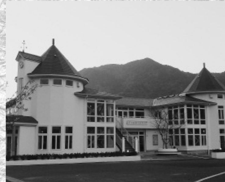
正面からの外観
