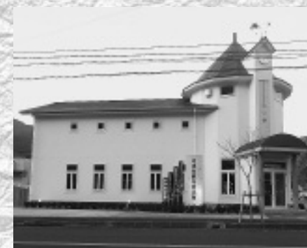
町道 浜峰線からの外観
