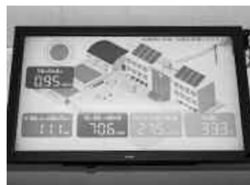
モニター画面に日射量、発電電力などを表示 環境教育用としても活用できます
