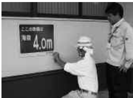
海抜表示板取り付け作業（浜公民館）
