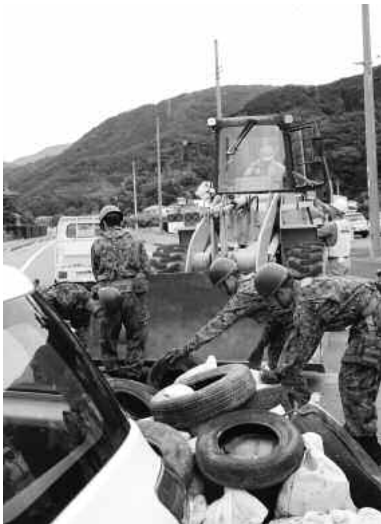
道路啓開訓練で散乱しがれきを撤去する陸上自衛隊員
