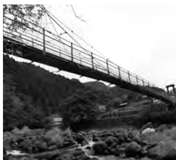
予備設計業務を行う川久保橋(川横地内)
