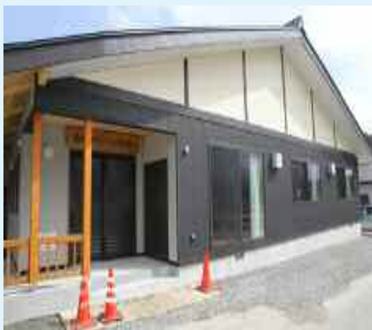
完成した「堀之内高齢者支え合いセンター」
