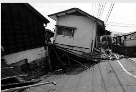
益城町の被害状況（写真提供：県建築安全推進課）
