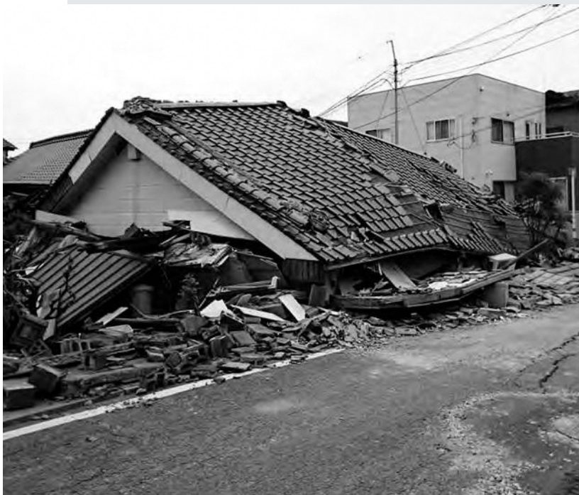
熊本地震（平成28年）で倒壊した木造住宅 （写真提供：県建築安全推進課）
