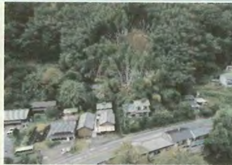
↑ 台風19号でのがけ崩れ(静岡市清水区)
