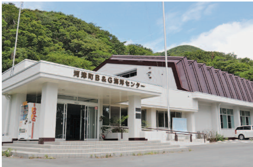
河津町B&G海洋センター体育館
