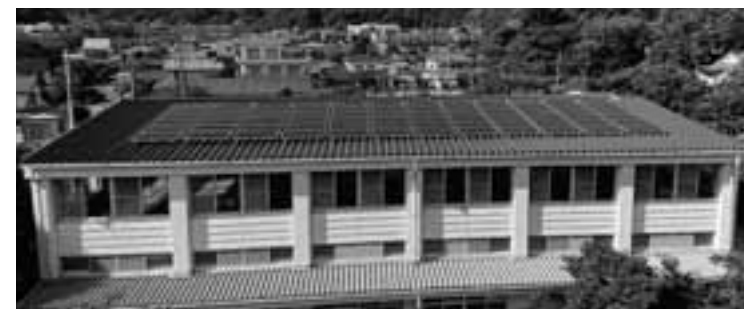
河津中学校太陽光パネル
