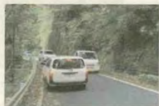
国道414号（未改良のためすれ違いが困難）
