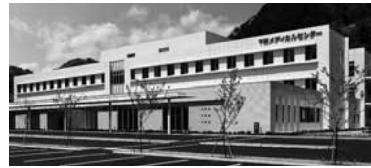
下田メディカルセンター
