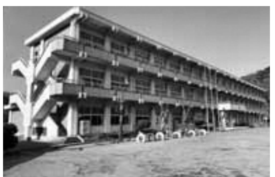
・小学校統合に向けたトイレの改修工事 2056万円
