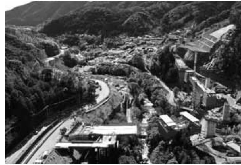
工事が進むインターチェンジ周辺
