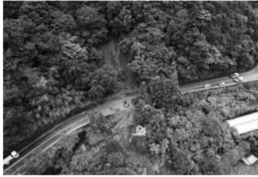
ドローンによる梨本地内の土砂崩れの映像
