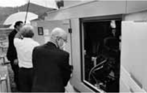
給食センター自家発電装置視察
