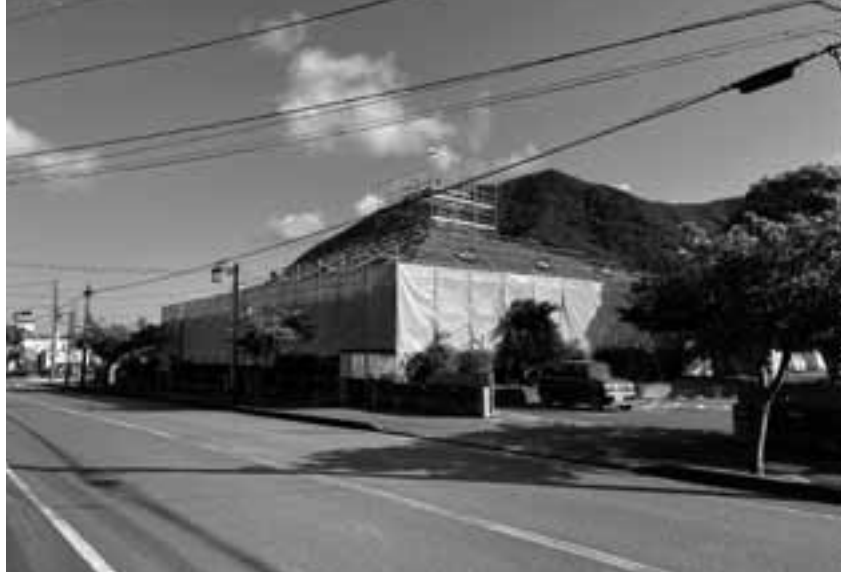
長寿命化工事中の文化の家
