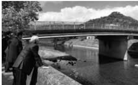
◁長寿命化補修工事が決まった「館橋」にて老朽部分の確認と工法や工期、通行止めなどの予定を視察し確認を行った。
