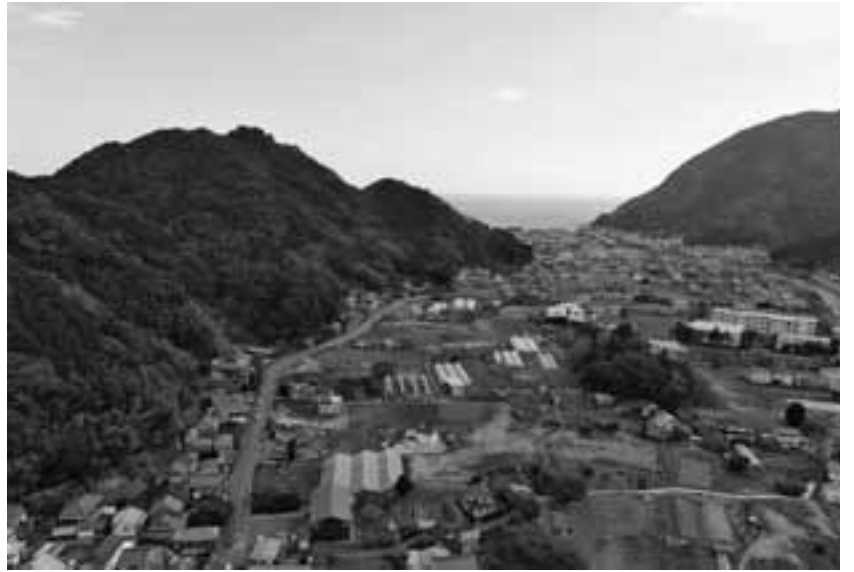
都市計画道路「浜峰線」未整備区間
