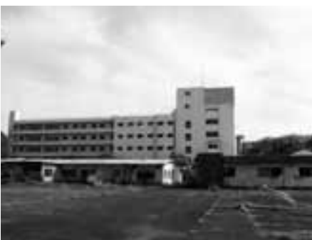
解体が決まった、旧共立湊病院
