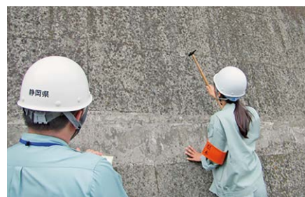
▲亀裂がないかチェック
