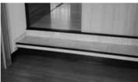
工事予定の段差手すりとステップ台を設置予定
