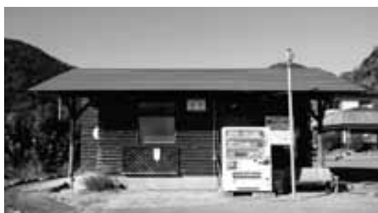
現在の七滝駐車場トイレ
