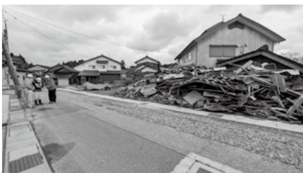
3人一組で調査を実施。築年数ある建物を中心に大きな被害・倒壊がみられた。
