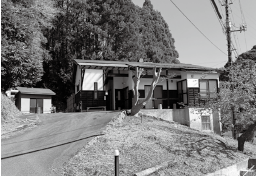
旧見高入谷高原温泉施設
