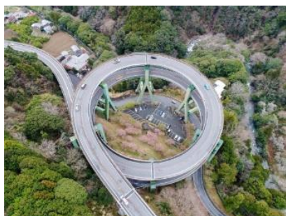
▼ 河津七滝ループ橋
