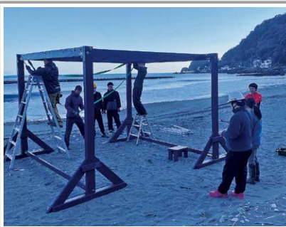
▲障害物レース直前、障害物の設置に取り組む
