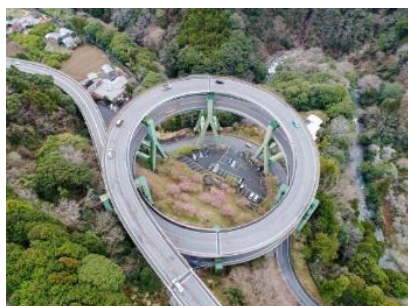
▼ 河津七滝ループ橋
