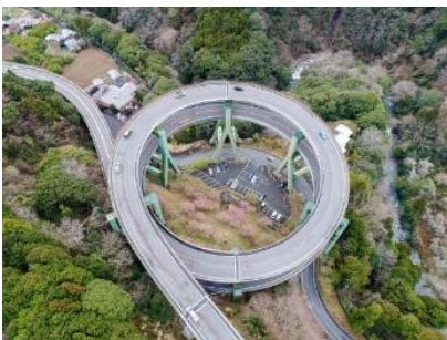
▼ 河津七滝ループ橋
