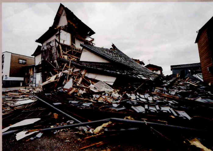
全壊した木造家屋（輪島市）
