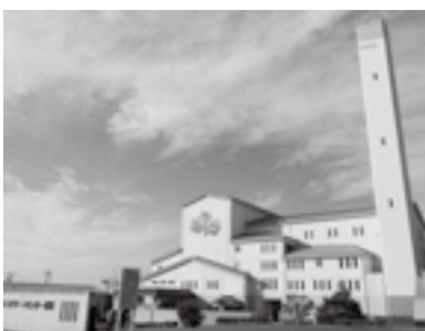
東河環境センター
