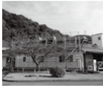
修繕中の文化の家図書館
