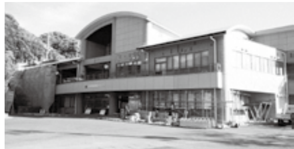
工事囲いは12月に撤去され1月末に終了
