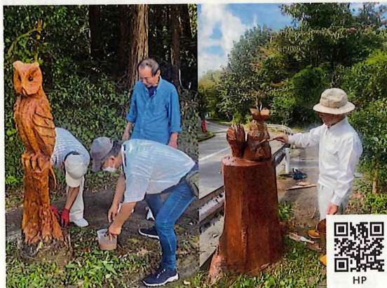
防腐剤を塗布する
