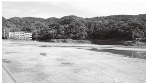
更地化完了した旧共立湊病院跡地
