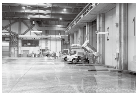
富士市新環境クリーンセンターピット
