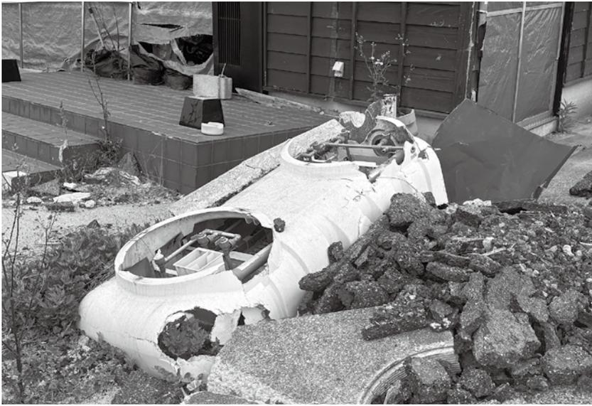
能登半島地震で揺れにより浮き上がり破損した浄化槽
