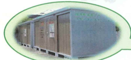
家庭用資源ごみリサイクルステーション外観
