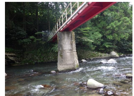
写真-2 P2橋脚(早期措置段階)
