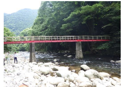
写真-1 天川橋全景
