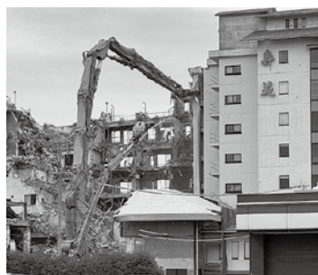
解体中のホテル
