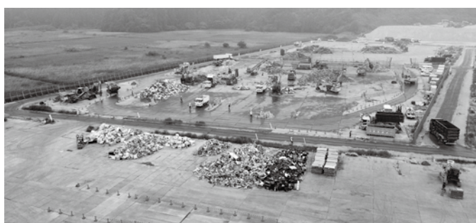
災害廃棄物処分場
