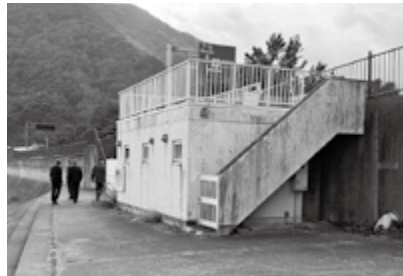
河津浜海岸公衆トイレ 解体撤去 466万円
