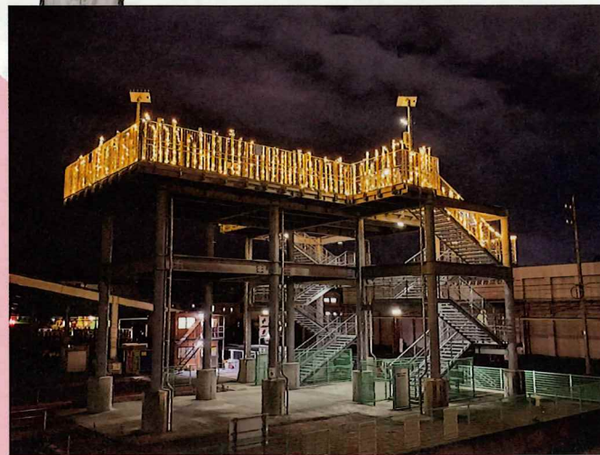
用宗漁港を照らす津波避難タワー
