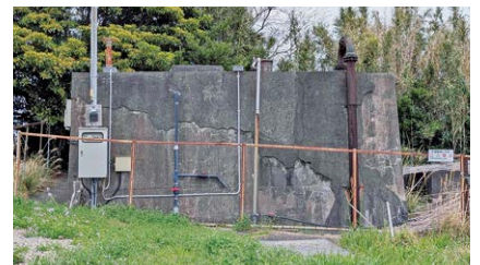
▲朝日台配水池
