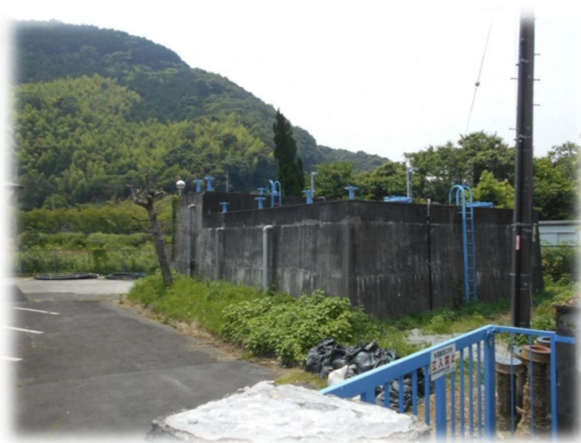
写真 3-1 大堰浄水場（着水井、浄水池）
