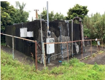
写真 6-1 長野朝日台配水池
