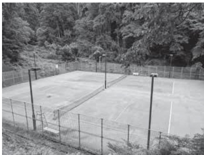
コート2面と照明の改修工事
